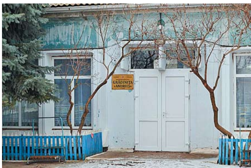
Grădinița „Andieș” din Zaim după reparație. Foto: Primăria Zaim
