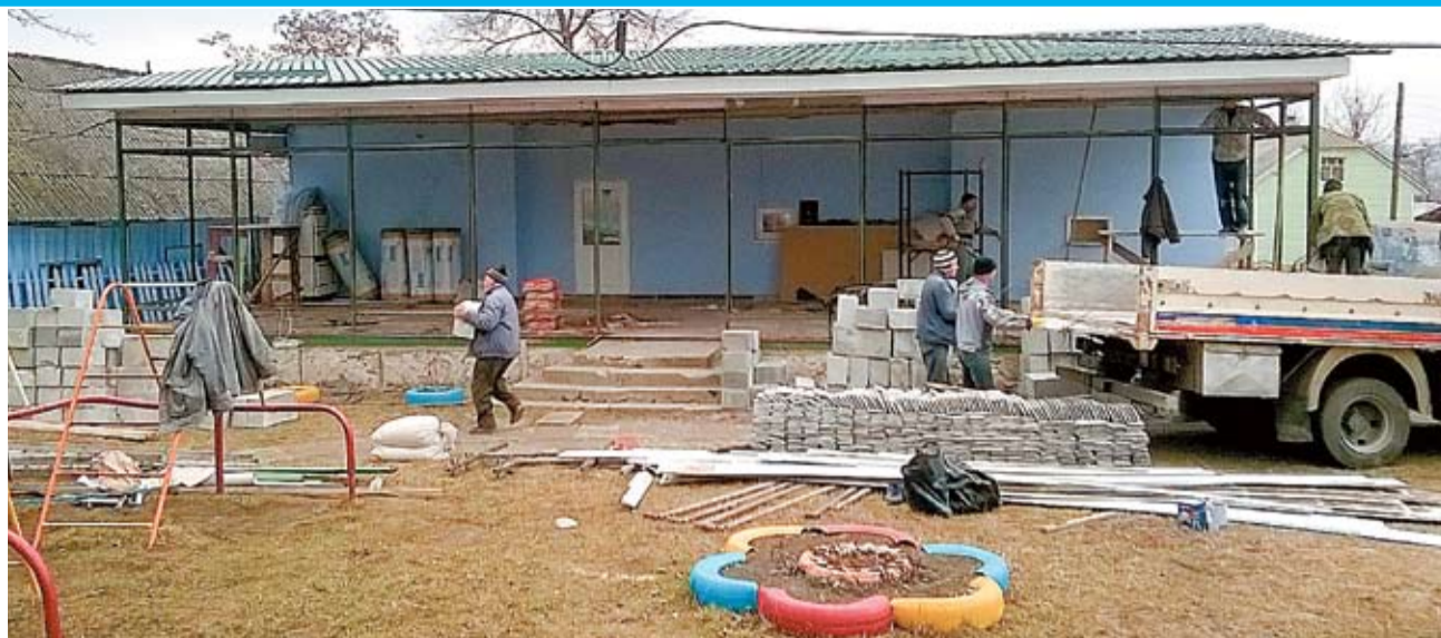
Clădirea anexă în construcție. Foto: Pimăria Gordinești
