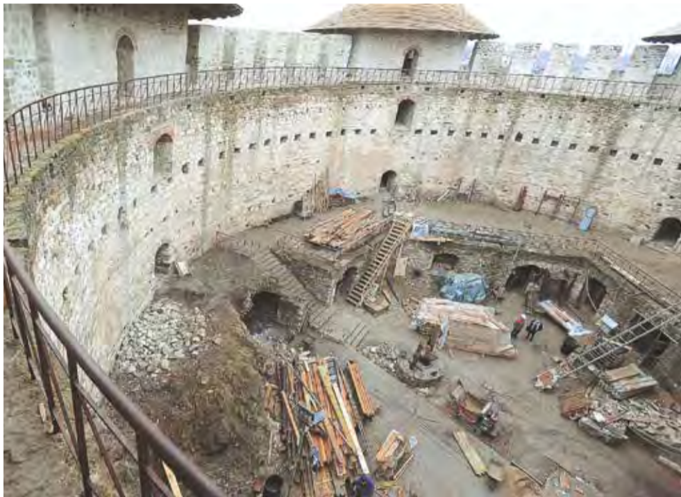
Lucrările de renovare în interiorul cetății. Foto: Constantin Grigoriță
